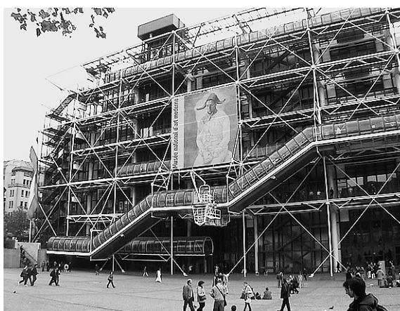
▲ポンピドゥー・センター。むき出しのパイプとガラス面で構成された外観
