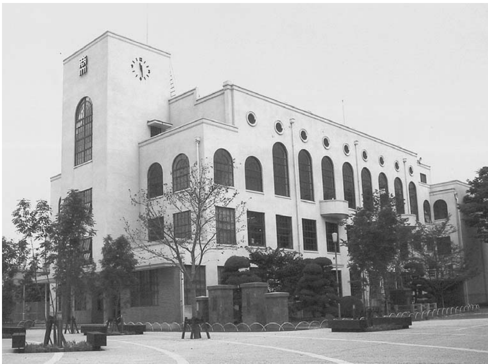
谷岡記念館 現状全景 (南東から)
