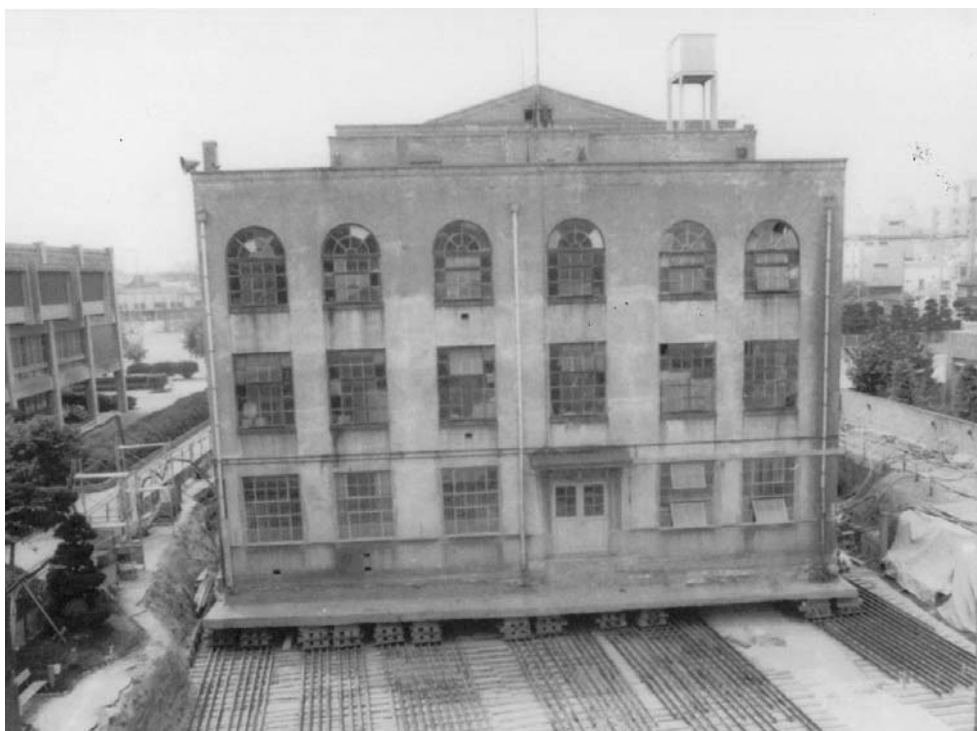
移設工事中の谷岡記念館
