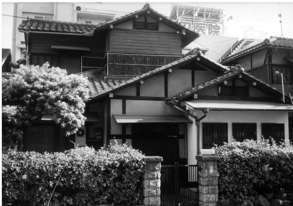
現存する第3号住宅の(ハ)の1 外観(No.8)
